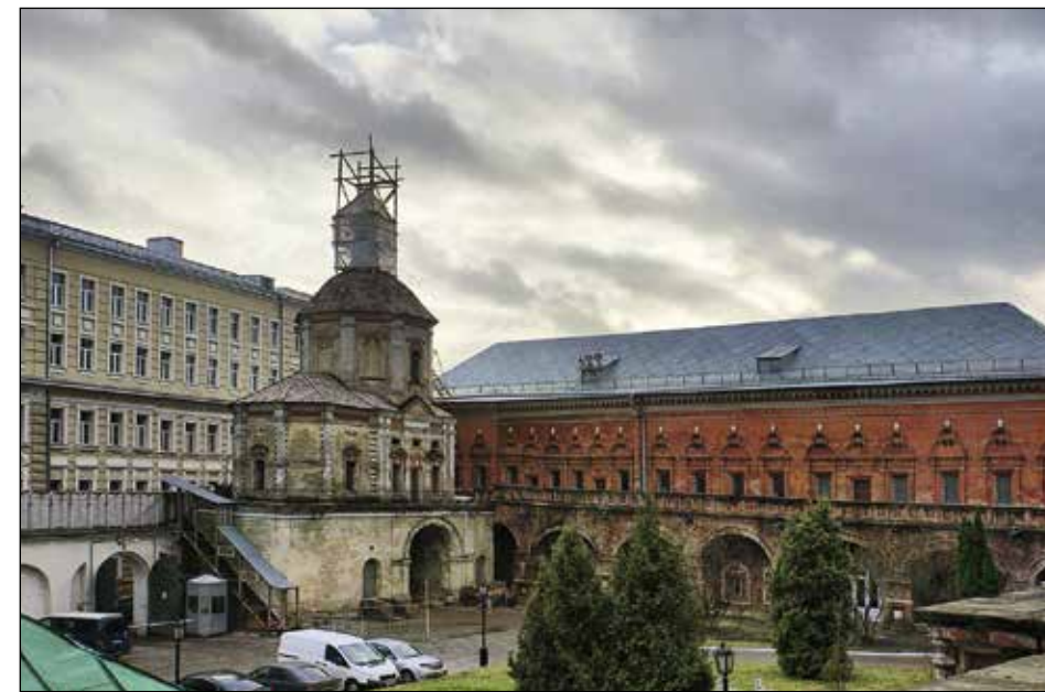
Петропавловская надвратная церковь вступила в активную фазу реставрации
