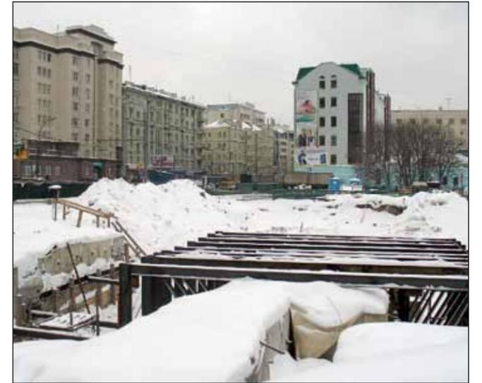
В котловане уже подготовлена опорная конструкция
