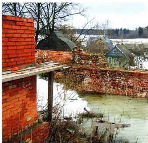
Вид сводов храма сверху со стоящей в пазухах водой
