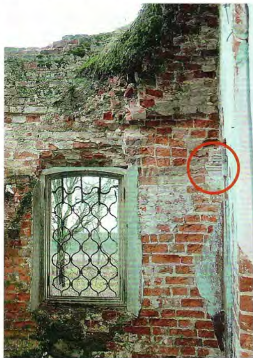
Для реставрации важно сохранить любые, даже мельчайшие элементы. Фрагмент штукатурного карниза конца XVIII века — единственный сохранившийся на весь алтарь
