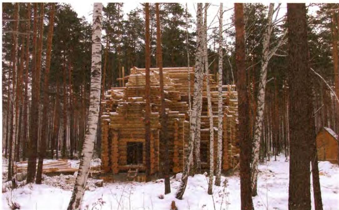
Строящийся Никольский храм
