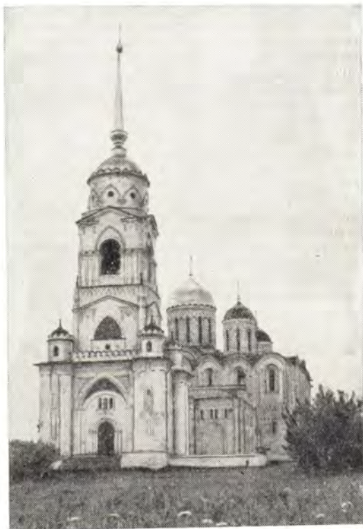
Успенский кафедральный собор (до начала реставрационных работ)
